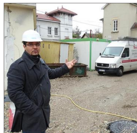
La maison des associations voisine, qui devait être détruite, restera finalement debout. Une place avec un arbre, une sculpture et un abri pour deux-roues verra le jour entre les deux bâtiments.
