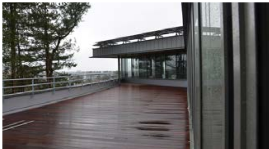
Deux terrasses de chacune 150 m 2 ont été aménagées au troisième étage de Deltagreen. Des balcons occupent les extrémités de chaque niveau.
