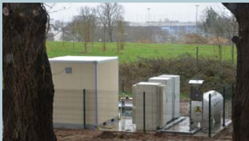
Une pile à combustible alimentée par l'hydrogène permettra de faire face aux besoins d'énergie, notamment l'hiver.
