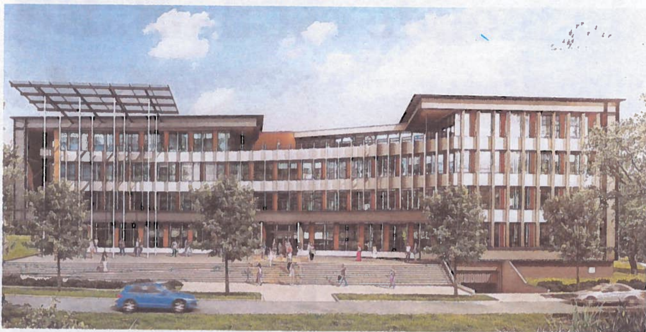
Sur le toit, des panneaux photovoltaïques, au sol, des dalles actives chauffent les locataires grâce à des pompes qui puisent la chaleur sous terre. À l'extérieur, une station hydrogène stocke l'électricité. C'est la première fois en France qu'un bâtiment tertiaire s'équipe d'hydrogène.
